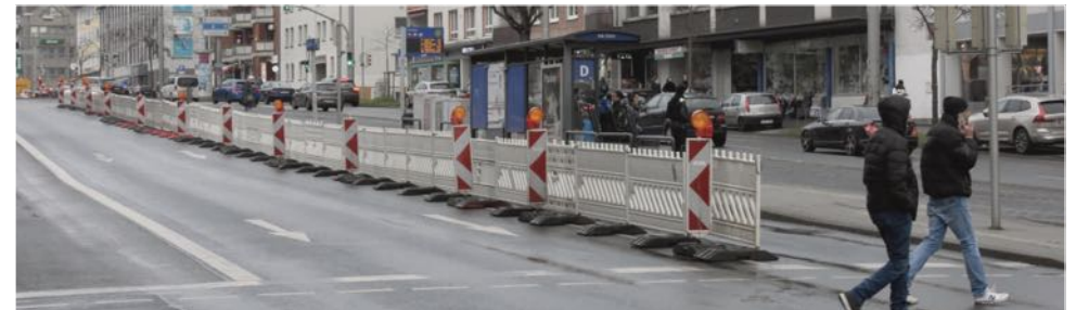
Die in der Vergangenheit bewährte Abtrennung der Haltestelle durch Schrankenzäune. Hier im Jahr 2023 ging die Verbreiterung bis zum Überweg, dadurch gab es keine Engstelle beim Betreten der Haltestelle.
