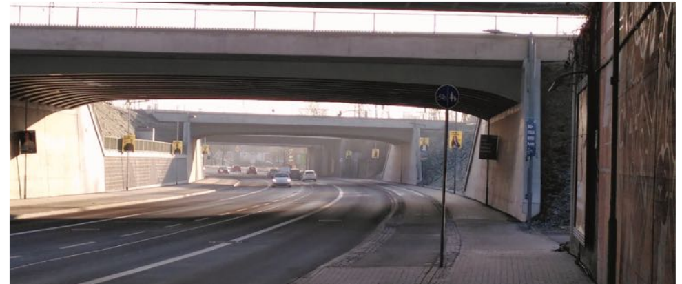
Wolfhager Straße in Höhe Drei Brücken nach Abschluss der Bauarbeiten. Foto Reinhard Ardelt
