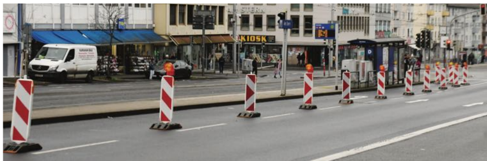
Die ersten Tage des Weihnachtsmarktes fehlte die Verbreiterung der Haltestelle Am Stern komplett. Nach einigen Tagen wurde die linke Spur dann provisorisch mit Verkehrsbaken abgesperrt.
