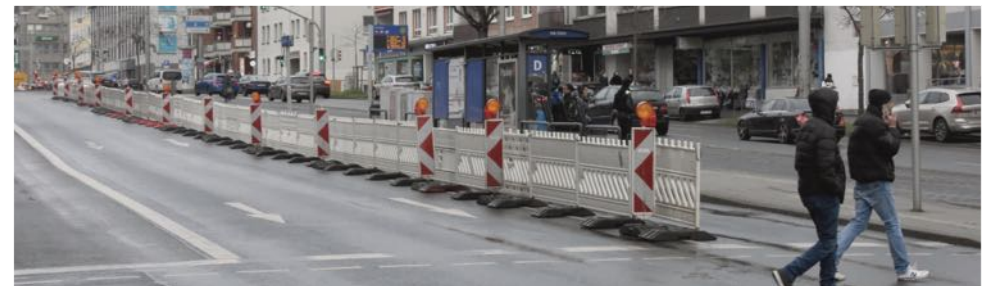
Die in der Vergangenheit bewährte Abtrennung der Haltestelle durch Schranken- zäune. Hier im Jahr 2023 ging die Verbreiterung bis zum Überweg, dadurch gab es keine Engstelle beim Betreten der Haltestelle.
